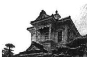
旧鶴岡警察署庁舎(鶴岡市)
