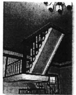
▲西田川郡役所の2階から塔に登るつり階段。下から支える柱がなく、まるで天守閣に登る細い階段のよう。
