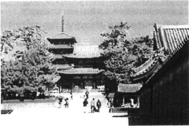
西院伽藍遠景
