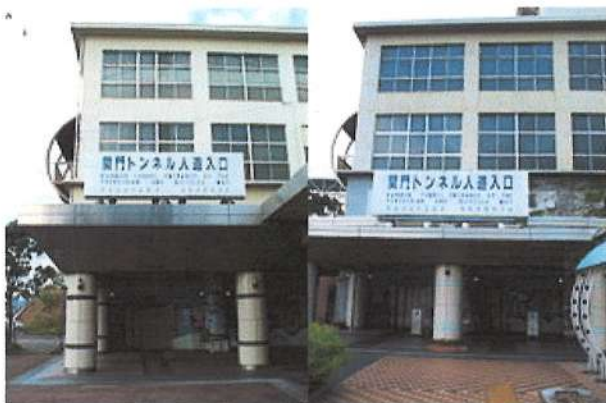
人道出入口。左は門司側、右は下関側
